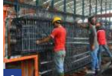
Pemasangan Tulangan atau Selongsong Installation of Reinforcement or Sleeves
