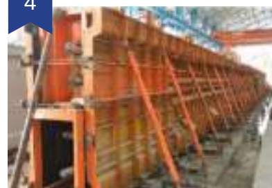
Pemasangan Dinding Cetakan Prefab Wall Mounting
