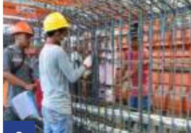
Perakitan Tulangan atau Selongsong Assembly of Reinforcement or Sleeves
